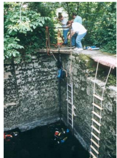
problematischer Zugang (Source de Landenouse)
