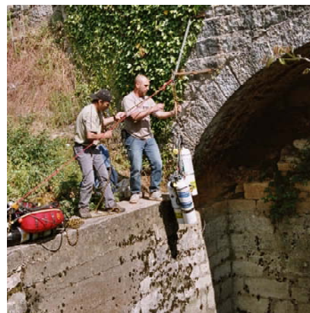
Einsatz von Hebegerät
